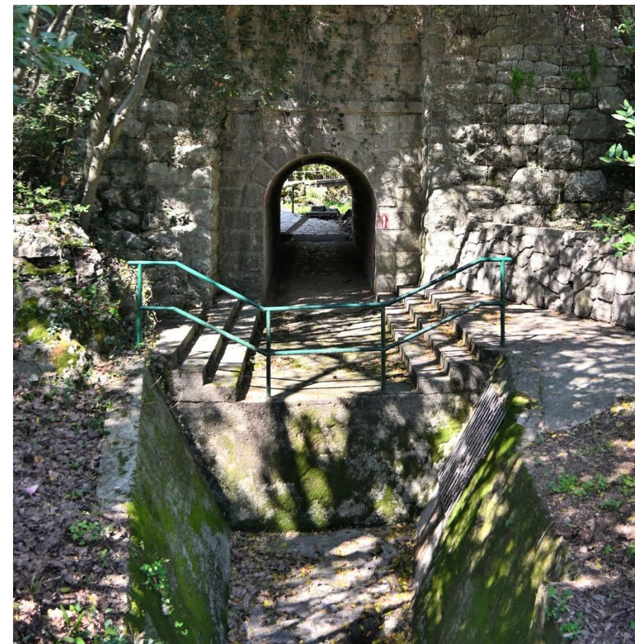
Sl. 42. Kanalizirano korito potoka Vrutka uzvodno od zatvorene dionice na predjelu Slatina
