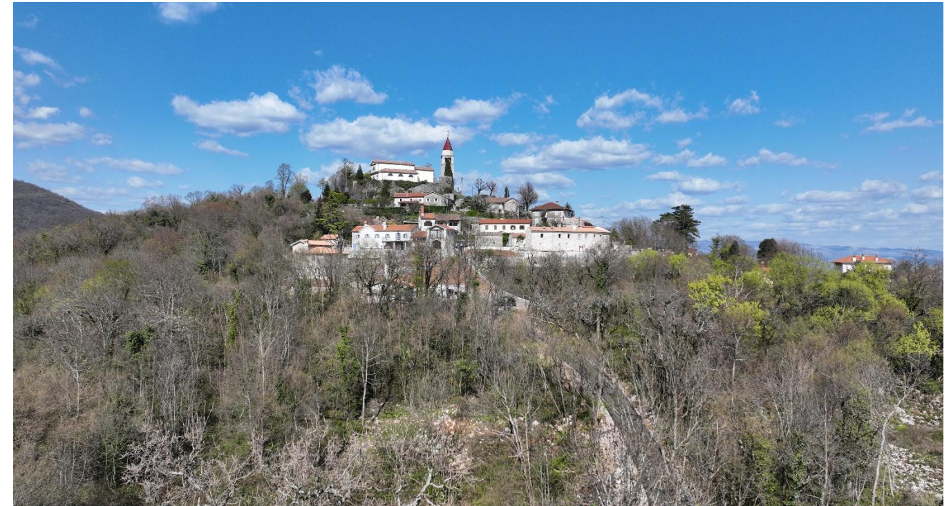
Sl. 13. Stara jezgra Veprinca
